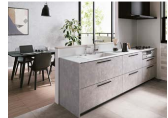
キッチンセットの交換を伴う対面化改修、 ビルトイン食器洗機、節湯水栓： システムキッチン ザ・クラッソ
