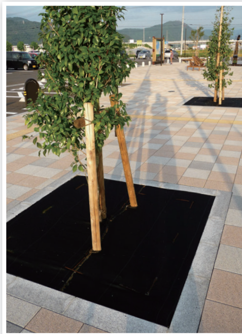
駐車場内の遊歩道
