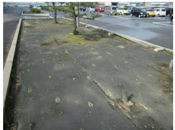
施工現場の様子 (施工後10年程度経過)
