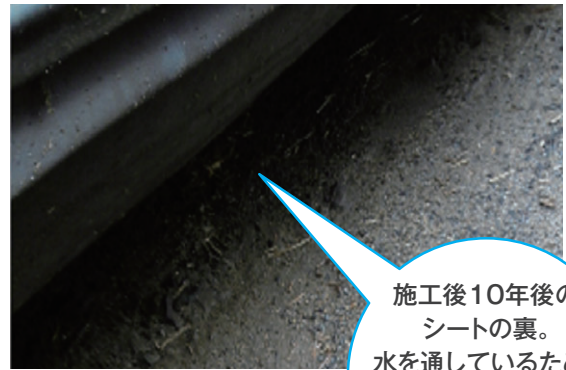
※写真は施工例です。
