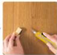
クリア色のスティックを「電気コテ」に押し付け、溶かして傷の部分に塗り、山盛りの状態にします。
