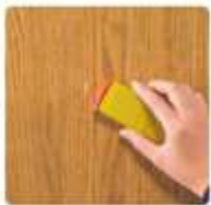
余分についたスティックをプラスチックヘラのギザギザの面でごさす。補修面を平らにします。
