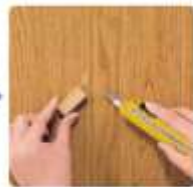
床と同色のスティックを「電気コテ」に押し付け、溶かして傷の部分に塗り、山盛りの状態にします。
