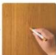
床と同色ペンシルで傷の部分に塗り込みます。
