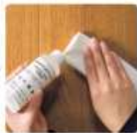
「リキッドサンドペーパー」をやわらかい布にしみ込ませ、軽くこするようしてさらに平滑にします。
