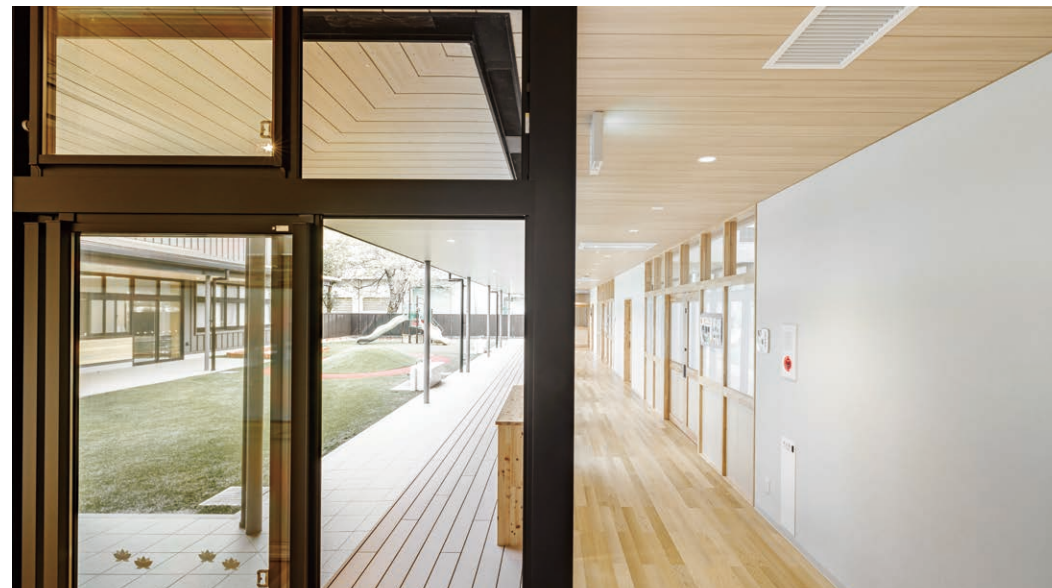
天井材 (右側): グラビオ羽目板V<クリアベージュ> 軒天井材 (左側): ダイライト軒天羽目板<クリアベージュ>
