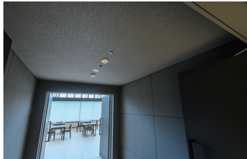
天井材:ダイロートン メタリック(トラバーチン(ブラック))
