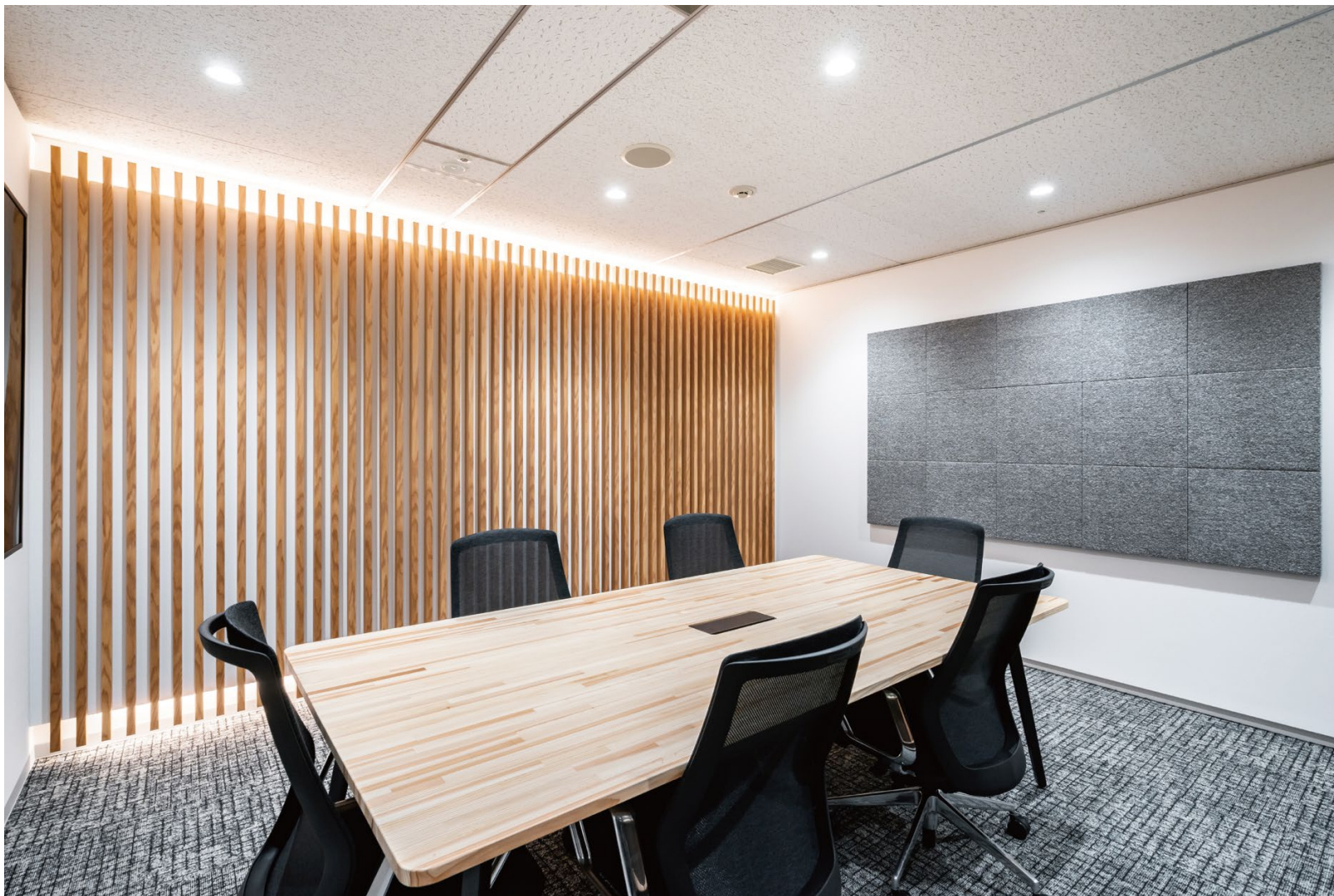
壁造作材：グラビオールバー US<US11 (スギ)> 吸音パネル：OFF TONE (オフトーン) マグネットパネルN<RP柄>〈02〉
