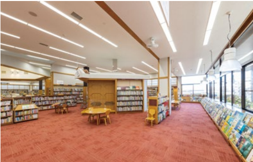
耐震天井工法: ダイケンハイブリッド天井 天井材: ダイロートントラバーチン9mm
