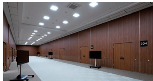
耐震天井工法：ダイケンハイブリッド天井 天井材：ダイロートン トラバーチン 12mm 不燃壁材：グラビオUB (UB27)
