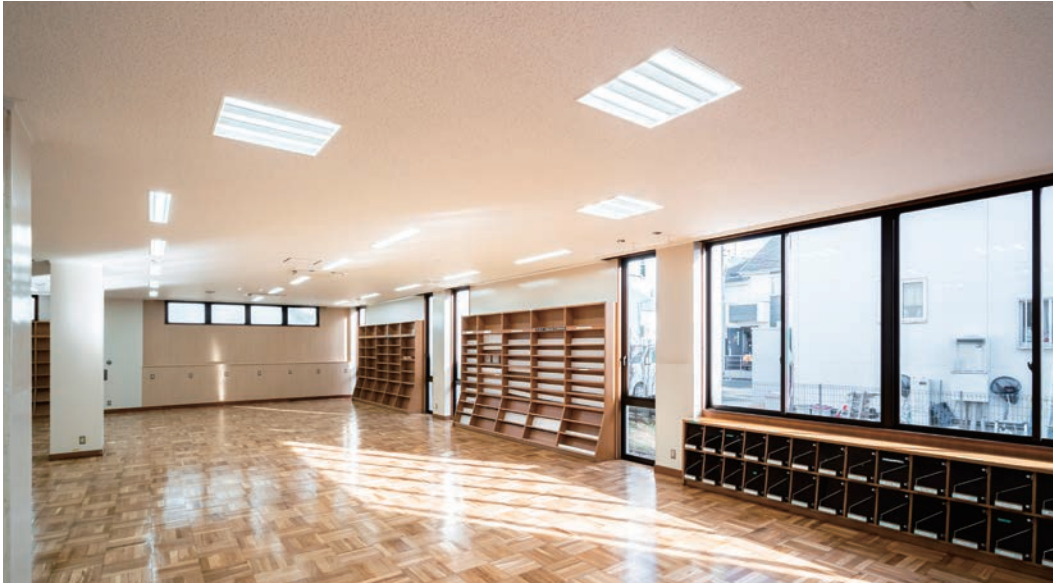
耐震天井工法：ダイケンハイブリッド天井 天井材：ダイロートン トラバーチン12mm
