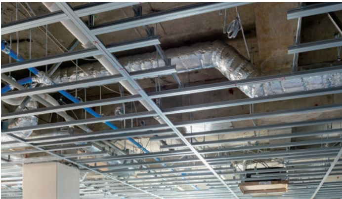
耐震天井工法：ダイケンハイブリッド天井
