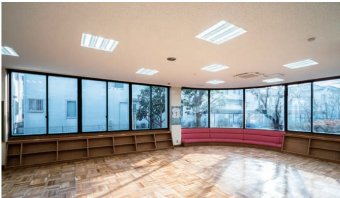
耐震天井工法：ダイケンハイブリッド天井 天井材：ダイロートン トラバーチン12mm
