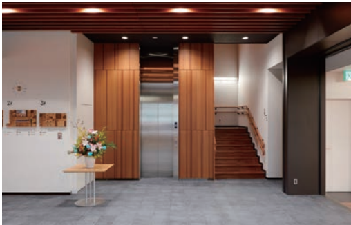
壁材: 福井県産スギ突板張り ダイライト不燃パネル<ティーブラウン>
