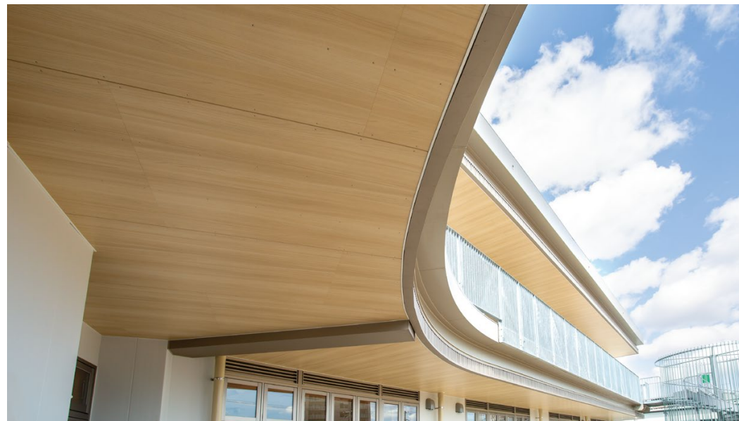
軒天井: ダイライト軒天30〈クリアベージュ〉
