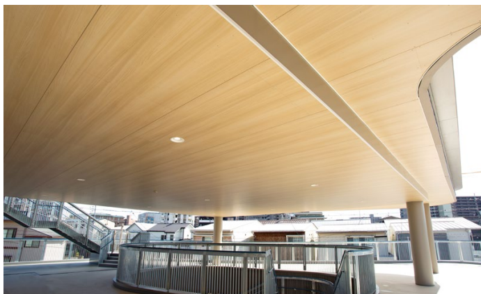
軒天井: ダイライト軒天30〈クリアベージュ〉
