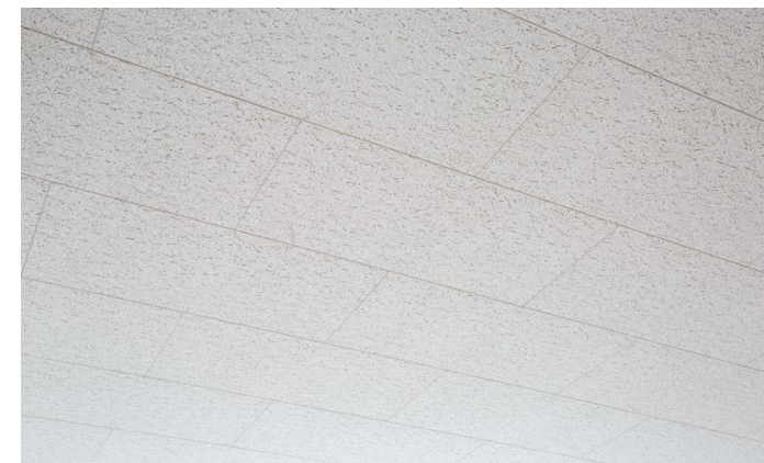
天井材: ダイロートンワイド直貼〈トラパーチン〉
