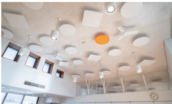
天井用吸音パネル:キントーン サークル〈ホワイト〉〈イエロー〉/キントーン スクエア〈ホワイト〉
