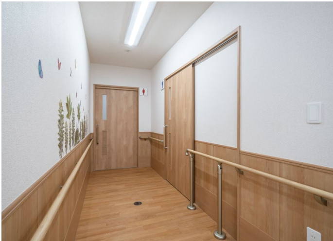
室内ドア：おもいやりドア〈ミルベージュ〉 壁材・腰壁：グラビオUB〈ミルベージュ〉 手摺：システム手摺35型〈ミルベージュ〉
