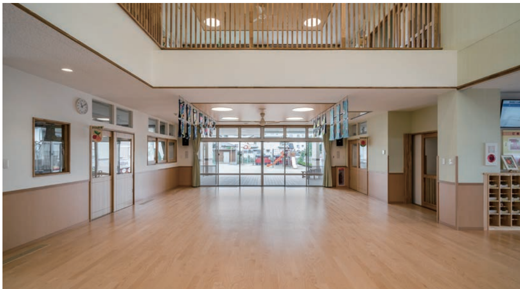
床材: ユカフィット〈カバ〉 全空気式床ふく射冷暖房システム: ユカリラ
