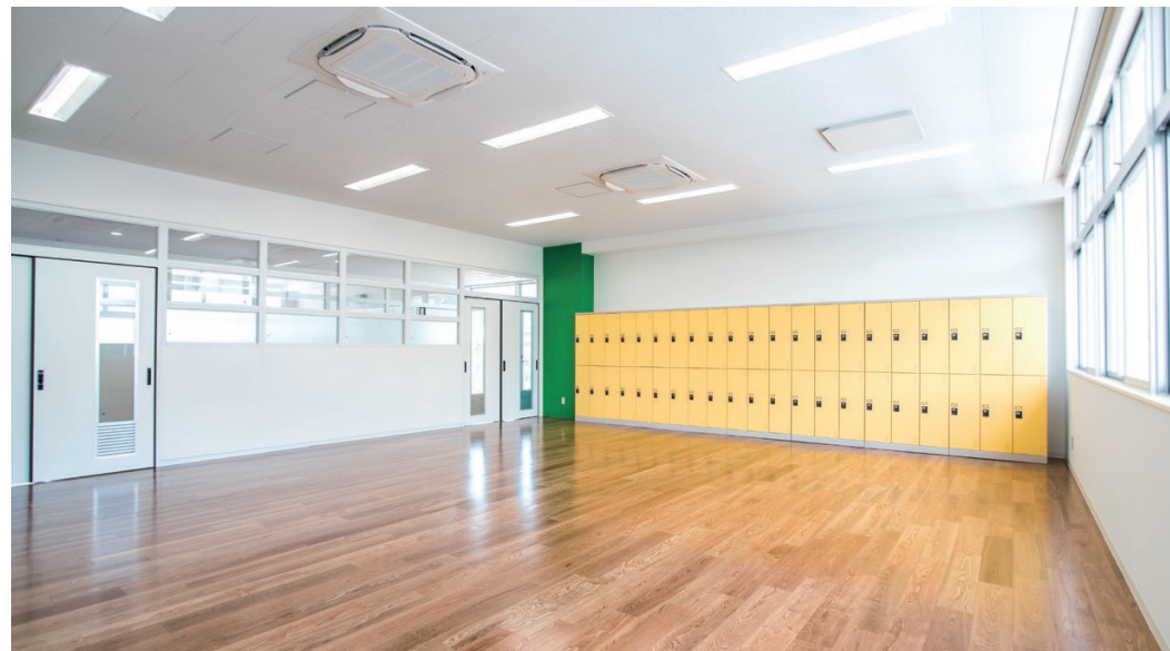
床材:土足対応WPC床材<ナラ(ブラウン)> 天井材:ロックウール化粧吸音板 ダイロートン ワイド直張<トラバーチン>
