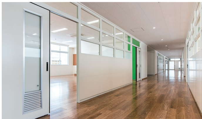
床材:土足対応WPC床材<ナラ(ブラウン)> 天井材:ロックウール化粧吸音板 ダイロートン ワイド直張<トラバーチン>
