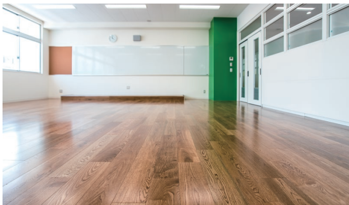
床材:土足対応WPC床材<ナラ(ブラウン)> 天井材:ロックウール化粧吸音板 ダイロートン ワイド直張<トラバーチン>
