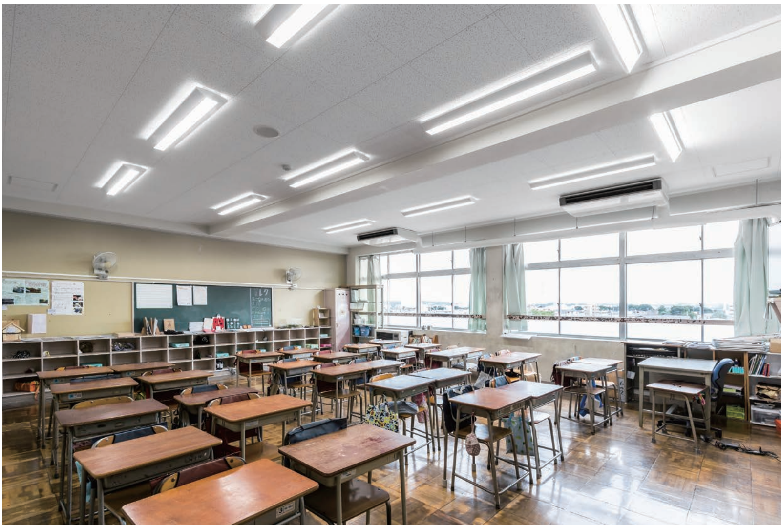
天井材:ロックウール化粧吸音板 ダイロートン 直張ベベル600 耐震天井工法:ダイケンハイブリッド天井
