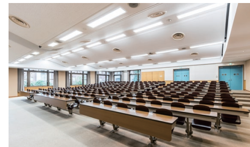
天井材:ロックウール化粧吸音板 ダイロートン トラバーチン9mm 耐震天井工法:ダイケンハイブリッド天井
