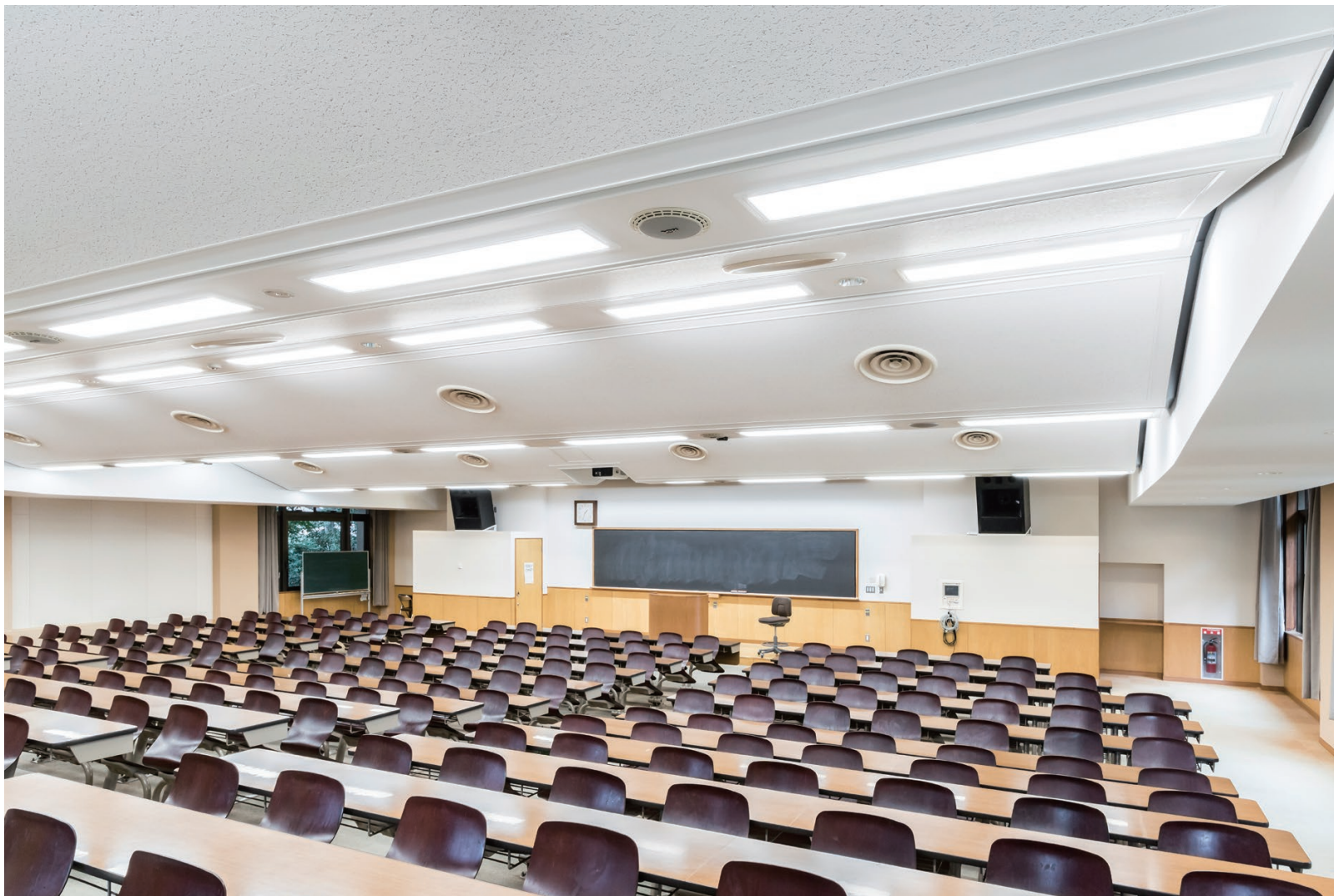
天井材:ロックウール化粧吸音板 ダイロートン トラバーチン9mm 耐震天井工法:ダイケンハイブリッド天井
