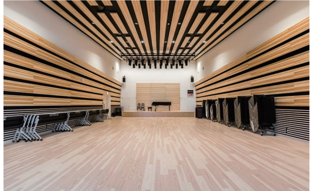
壁材: 大崎産スギ突板張りダイライト不燃パネル 床材: コミュニケーションタフ FW(地域産材対応突板)〈大崎産杉〉
