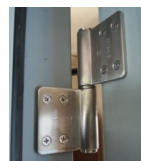
扉吊り込み後の丁番の様子
