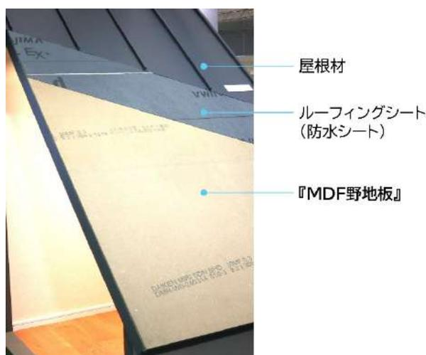
『MDF野地板』を下地材に用いた場合の屋根の構造イメージ
