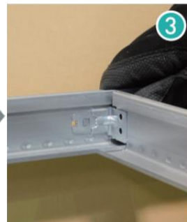
廊下幅に対応する長さのDHクロスをDHメインに差し込む
