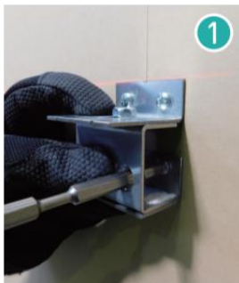
壁下地に対し廊下用支持金具をビス固定
