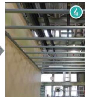
4 DHメインの通りを調整し下地組み完了
