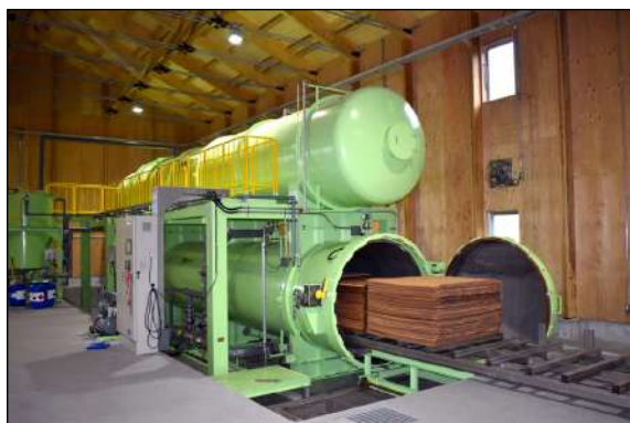
日南大建(株)新工場の製造設備
