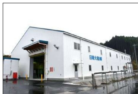
日南大建(株)新工場外観
