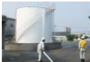
タンクへの冷却放水
