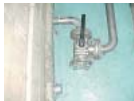
排水配管改良後
