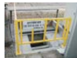
改修した排水路
