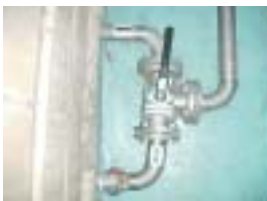
排水配管改良前
