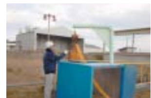
水中ポンプを用いて総合排水溝から排水回収
