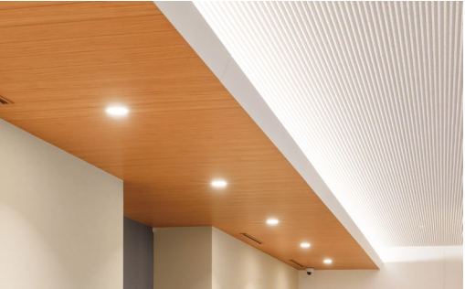
天井材（左側）：グラビオ羽目板V〈UB75（熊本杉柄）〉 天井材（右側）：ダイロートン リブ19mm〈I01〉
