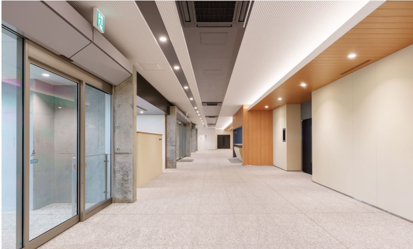
天井材（右側）：グラビオ羽目板V〈UB75（熊本杉柄）〉 天井材（左側）：ダイロートン リブ19mm〈I01〉
