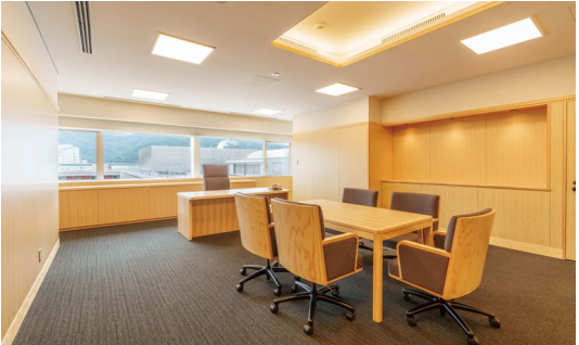
壁(木質部):ダイライトFAL(産業用基材)に岩手県産赤松突板練りつけ
