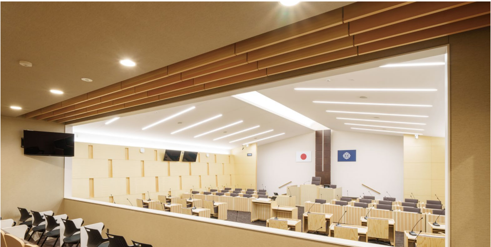
天井造作・壁(木質部):ダイライトFAL(産業用基材)に岩手県産赤松突板練りつけ
