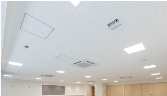
耐震天井工法：ダイケンハイブリッド天井 天井材：ダイロートン トラバーチン 9mm厚品
