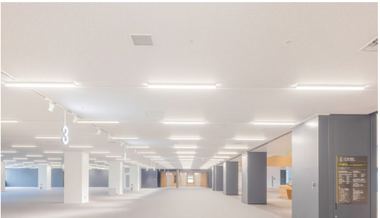
天井材：ダイロートン トラバーチン9mm厚品
