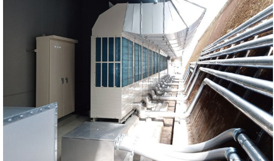
床下ダクトレス全空気式 床輻射冷暖房システム：室外機
