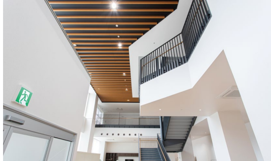
天井造作材:グラビオールバー UB 直付式(UB75(熊本杉柄))
