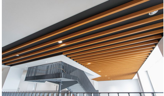
天井造作材:グラビオールバー UB 直付式(UB75(熊本杉柄))
