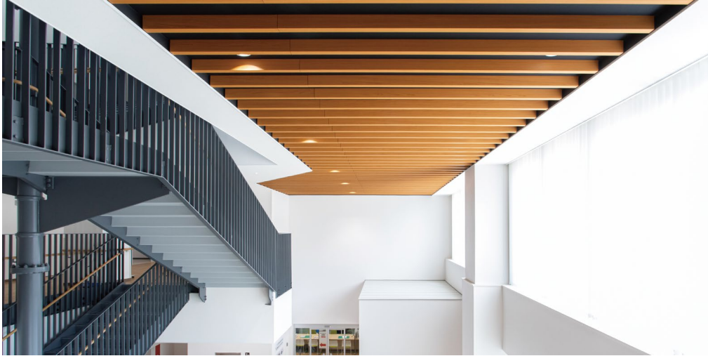
天井造作材:グラビオールバー UB 直付式(UB75(熊本杉柄))
