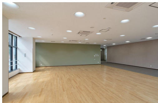
天井材：ロックウール吸音板 ダイロートン トラバーチン9mm
