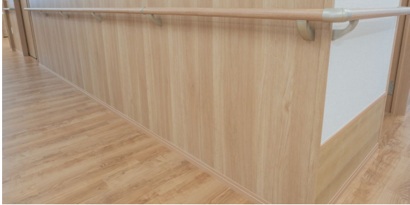
腰壁 (左側): グラビオUB<ライトオーカー柄> 腰壁 (右側): グラビオLB<ライトオーカー柄> 手摺: システム手摺35型 ベーシックタイプ手摺<ライトオーカー柄>
