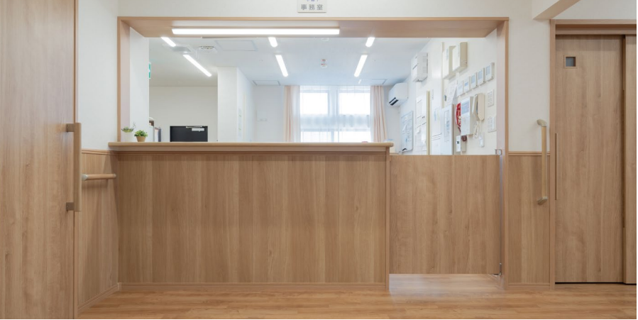
室内ドア (左側、右側): おもいやりドア<ライトオーカー柄> 室内ドア (カウンター右側): おもいやりドア (特注品)<ライトオーカー柄> 腰壁: グラビオUB<ライトオーカー柄> 手摺: システム手摺35型 ベーシックタイプ手摺<ライトオーカー柄> 造作材: 集成材カウンター (ゴム材)<ライトオーカー色>
