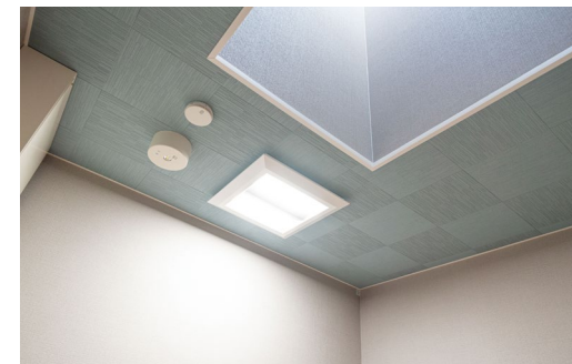
天井材：パステルトーン〈ブルー色〉
