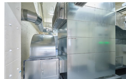
全空気式床輻射冷暖房システム：ダクトボックス
