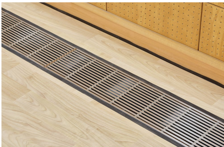
全空気式床輻射冷暖房システム：ユカリラ YGSタイプ
