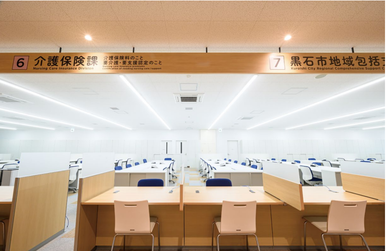
天井材：ロックウール化粧吸音板 ダイロートン 直張ベベル600
