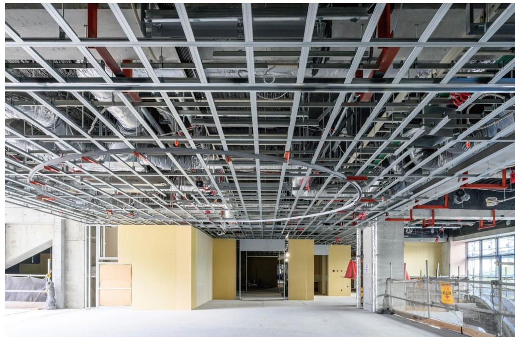
耐震天井工法: ダイケンハイブリッド天井 落下低減天井DH
