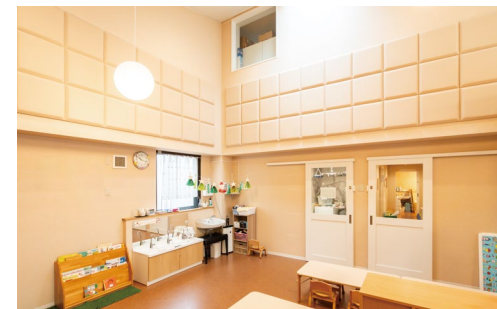
天井材:クリアトーン12SIIラインアート〈401〉 音響用インテリア壁材:オトピタ01〈ページュ〉
