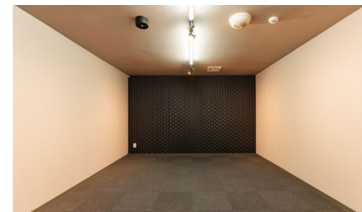
防音室用換気扇: 防音ダクト換気扇32C型 天井・壁下地材: 遮音パネル18.5 床下地材: オトユカベースN
