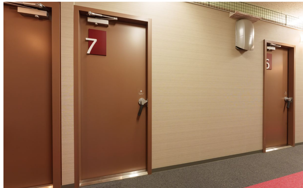
室内ドア: 防音ドア SFタイプ G45 フード: I穴用A防音防火ダンパー付フードI2型
