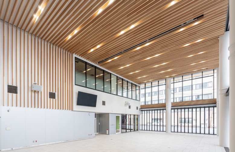
天井造作材:グラビオールバー US 直付式<大崎市産杉> 耐震天井工法:ダイケンハイブリッド天井
