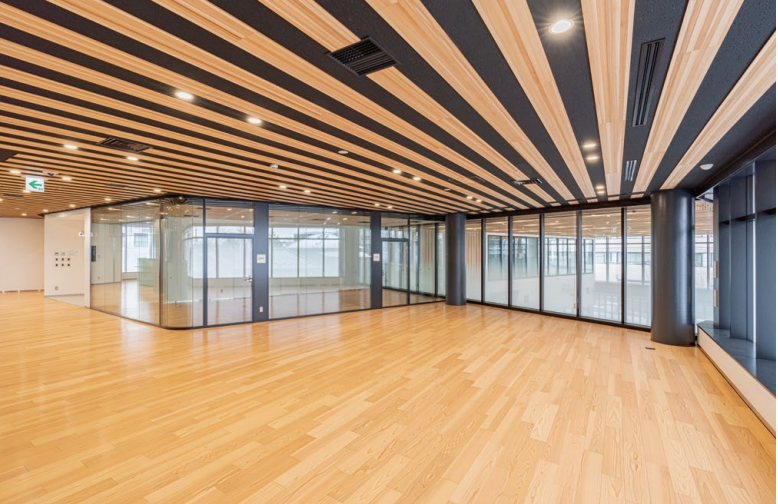
天井材:大崎産スギ突板張り ダイライト不燃パネル 床材:コミュニケーションタフII FW(地域産材対応突板)<大崎市産杉>
