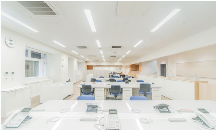
耐震天井工法: ダイケンハイブリッド天井 天井材: ダイロートン トラバーチン9mm
