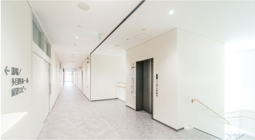
耐震天井工法: ダイケンハイブリッド天井 天井材: ダイロートン トラバーチン9mm
