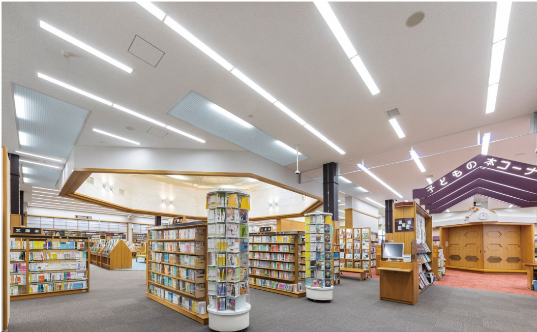
耐震天井工法: ダイケンハイブリッド天井 天井材: ダイロートトラバーチン9mm
