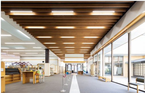
耐震天井工法: ダイケンハイブリッド天井 天井材: ダイロートトラバーチン9mm 天井造作材: グラビオルーバー UB 直付式〈ティーブラウン〉
