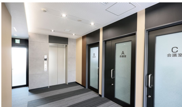
天井材:ロックウール化粧吸音板 ダイロートン トラバーチン9mm 天井材:ロックウール化粧吸音板 ダイロートン リブ12mm
