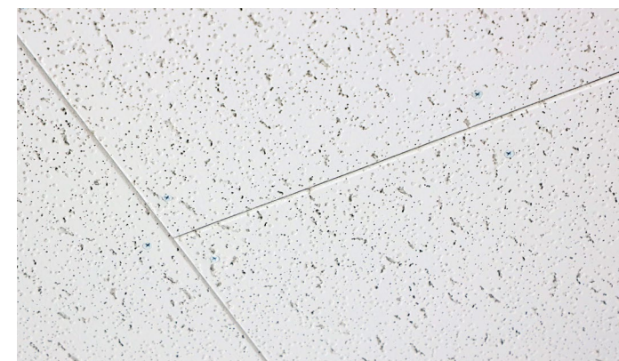
天井材:ダイロートン スクールトーン ワイド直貼り9mm
