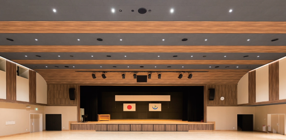
天井材：ダイロートン カラー（特注色）トラパーチン 9mm・12mm 耐震天井工法：ダイケンハイブリッド天井
