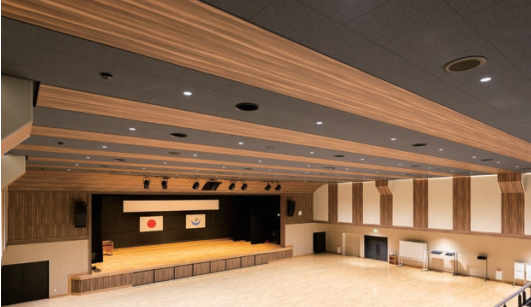
天井材：ダイロートン カラー（特注色）トラパーチン 9mm・12mm 耐震天井工法：ダイケンハイブリッド天井
