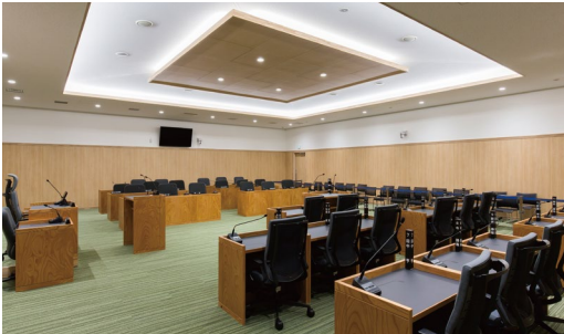
不燃壁材:グラビオUB<UB73> 天井材:ロックウール化粧吸音板 ダイロートン トラバーチン9mm
