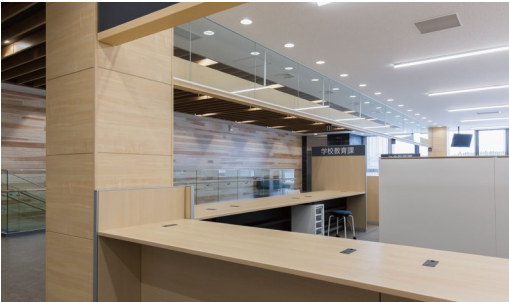
不燃壁材:グラビオUB<UB71> 天井材:ロックウール化粧吸音板 ダイロートン トラバーチン9mm
