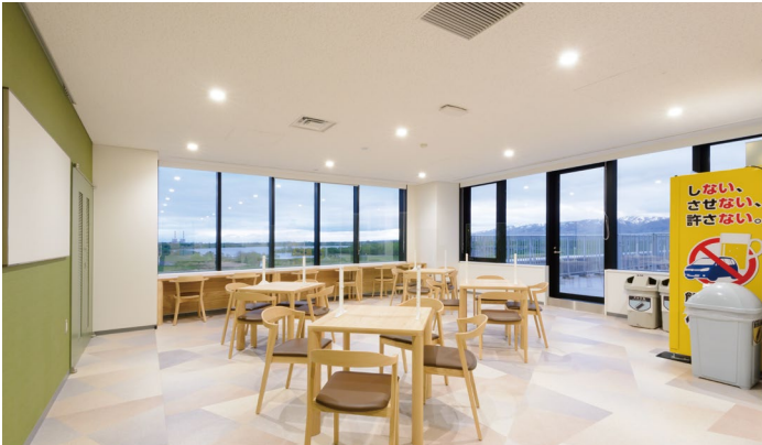
天井材：ロックウール化粧吸音板 ダイロートン トラバーチン12mm
