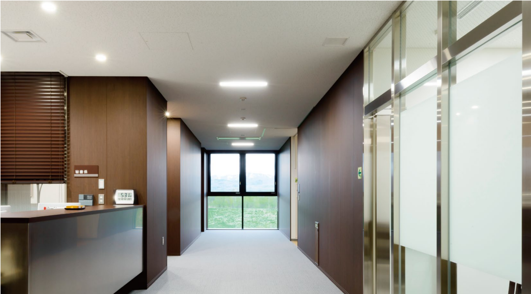
不燃壁材：グラビオフィットUB〈UB22〉・〈UB32〉 天井材：ロックウール化粧吸音板 ダイロートン トラバーチン12mm
