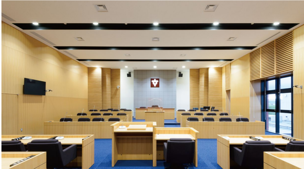
不燃壁材：グラビオフィットUB〈UB22〉 天井材：ダイロートン トラパーチン 12mm
