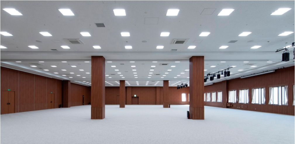
耐震天井工法：ダイケンハイブリッド天井／天井材：ロックウール化粧吸音板 ダイロートン トラバーチン12mm 不燃壁材：グラビオUB〈UB27〉・〈ティーブラウン柄〉
