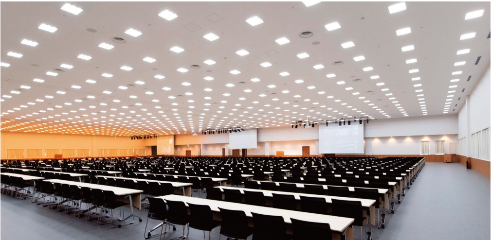
耐震天井工法：ダイケンハイブリッド天井 天井材：ロックウール化粧吸音板 ダイロートン トラバーチン12mm
