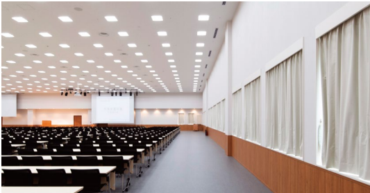
耐震天井工法：ダイケンハイブリッド天井 天井材：ロックウール化粧吸音板 ダイロートン トラバーチン12mm 不燃壁材：グラビオUB〈UB27〉・〈ティーブラウン柄〉
