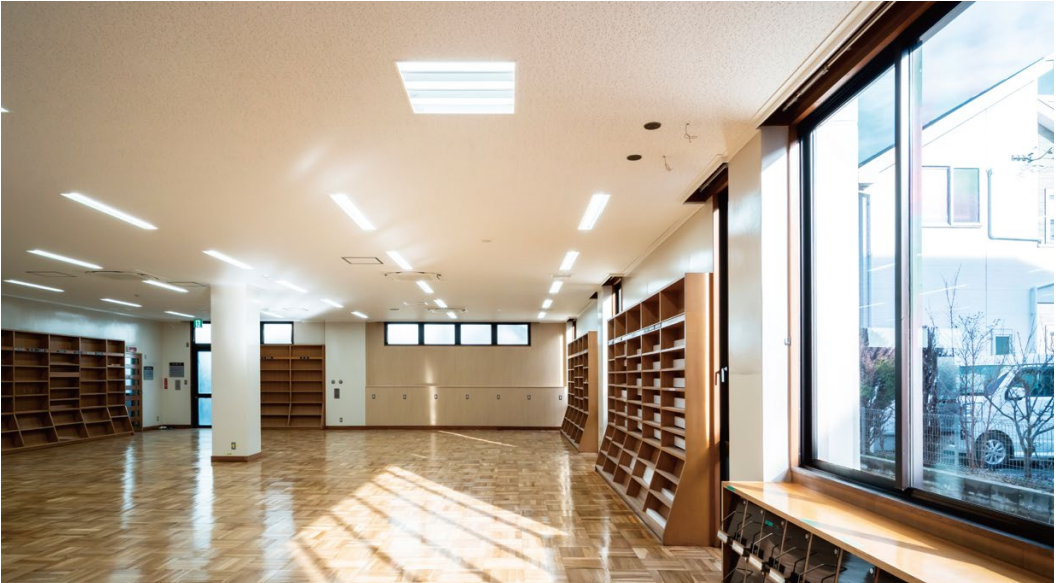
耐震天井工法：ダイケンハイブリッド天井 天井材：ロックウール化粧吸音板 ダイロートン トラバーチン
