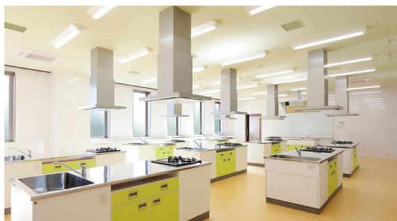
天井材：ロックウール化粧吸音板 ダイロートントラバーチン
