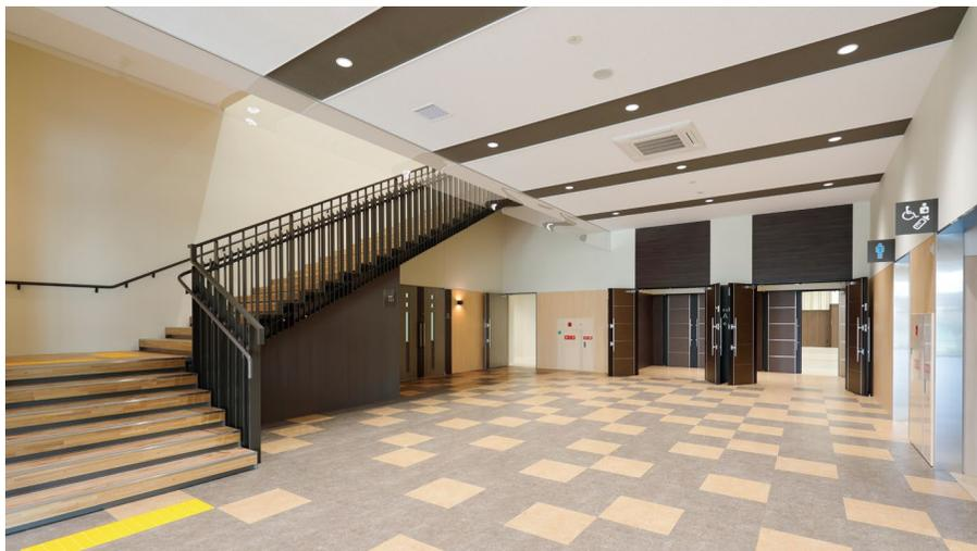
天井材：ロックウール化粧吸音板 ダイロートントラバーチン
