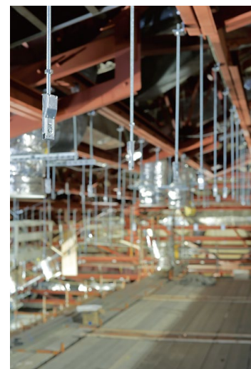
耐震天井工法：ダイケンハイブリッド天井
