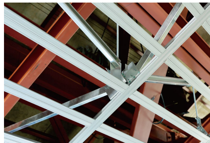
耐震天井工法：ダイケンハイブリッド天井
