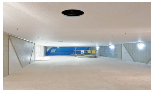
耐震天井工法：ダイケンハイブリッド天井 天井材：ロックウール化粧吸音板 ダイロートン ワイド直張〈トラバーチン〉
