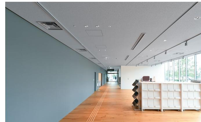
天井材：ロックウール化粧吸音板 ダイロートン ギンガ4
