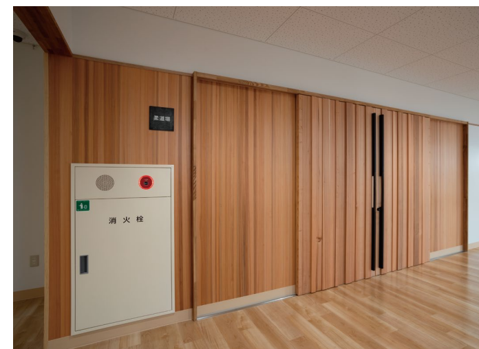
壁材：富山県産材スギ突板張り ダイライト不燃パネル
