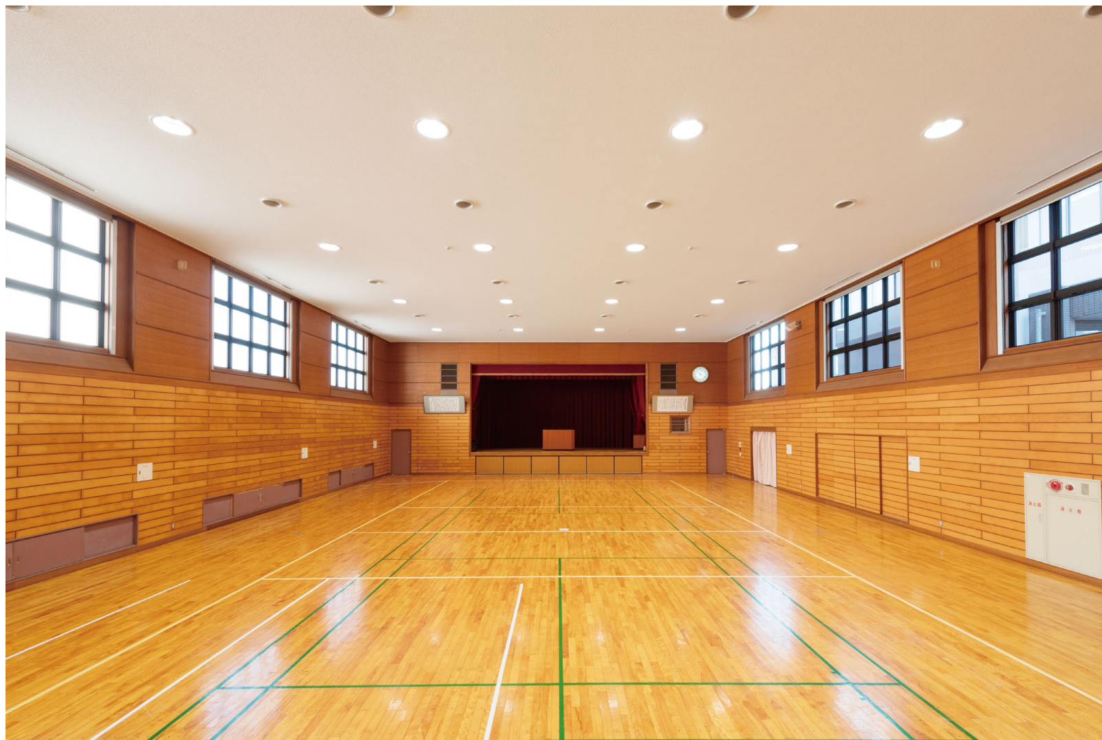
耐震天井工法：ダイケンハイブリッド天井 天井材：ロックウール化粧吸音板 ダイロートン トラバーチン
